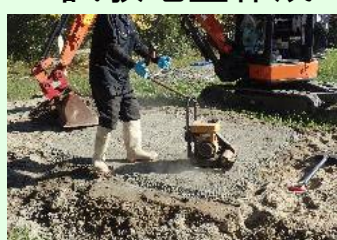
EBの敷固め
