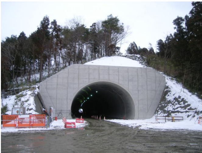
山元トンネル工事の様子
